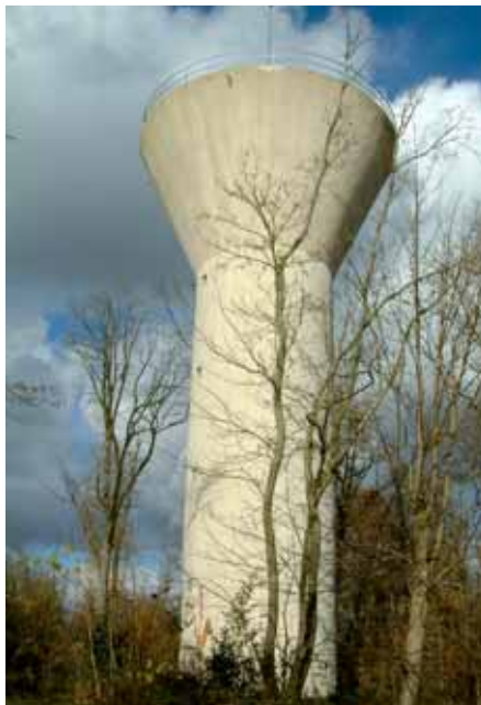
Château d'eau de Berchères Boisssets
